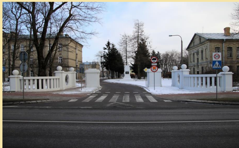
Brama po wykonaniu pierwszego etapu prac
