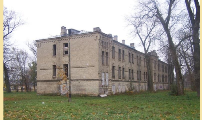
Budynek przed remontem (stan 2006 rok)
